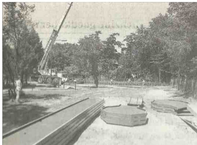
Met een grote kraan werden de viltbanen op hun plaats gelegd.
